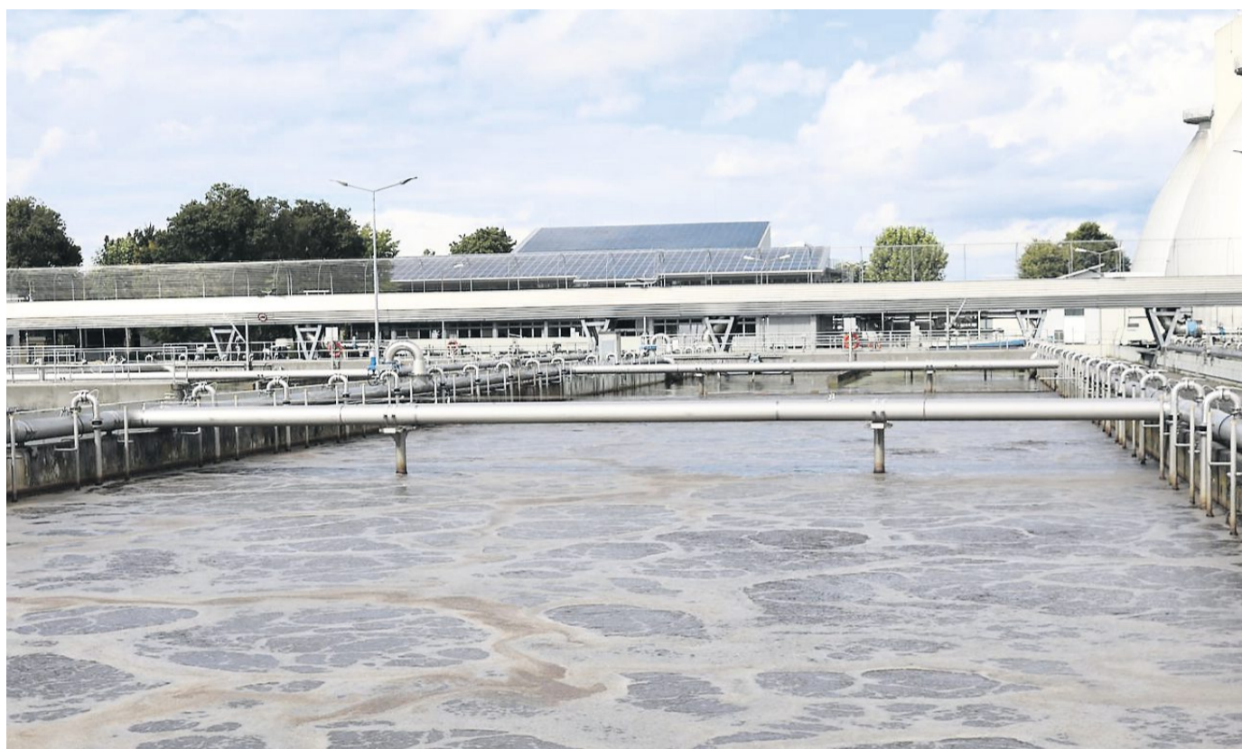
Im Klärwerk wird das Wasser des Einzugsgebietes gereinigt.
