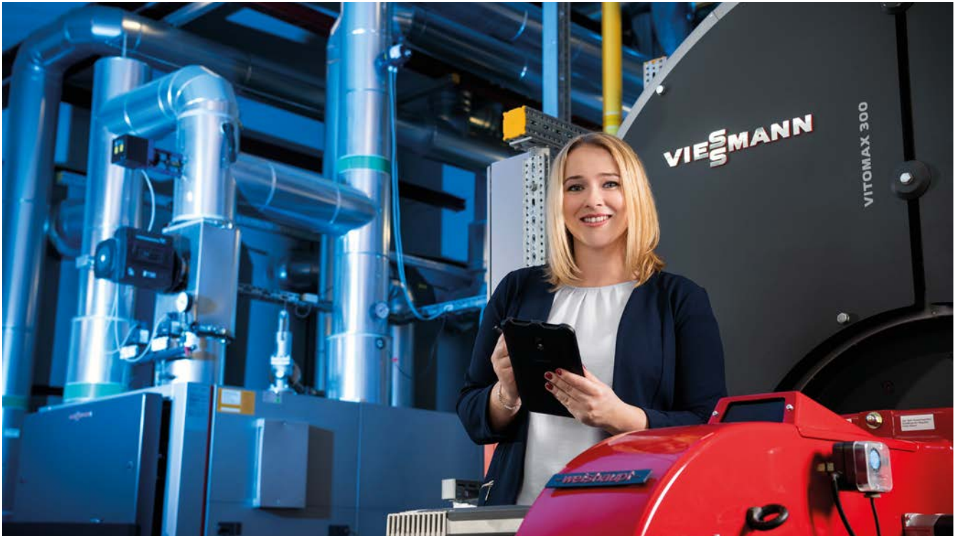
Sabrina Hoock vor dem BHKW in der Heizzentrale Lützelsachsen Ebene
