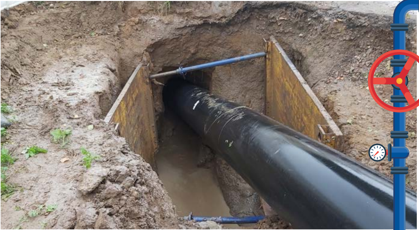
Unterquerung der neuen Weschnitz im Horizontalspülbohrverfahren
